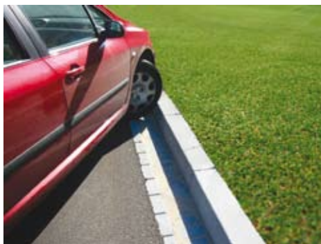
Najazd na krawężnik zwykły z niebezpieczeństwem zniszczenia krawężnika i koła
